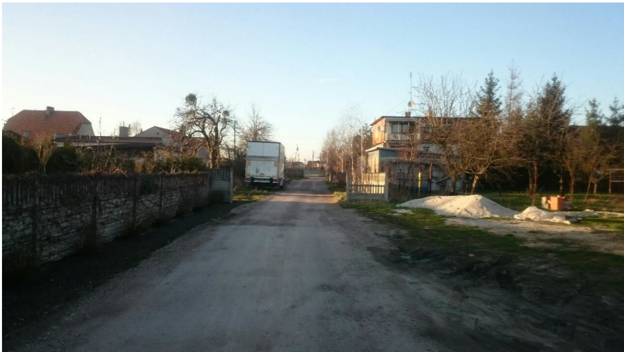
Zdjęcie 1 Początek opracowania- widok w kierunku ul. Garncarskiej
